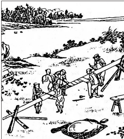
3 pav. Ruošiami bambukiniai apsaugos vamzdžiai (pagal Nachmanson ir Sundberg, 1936)
