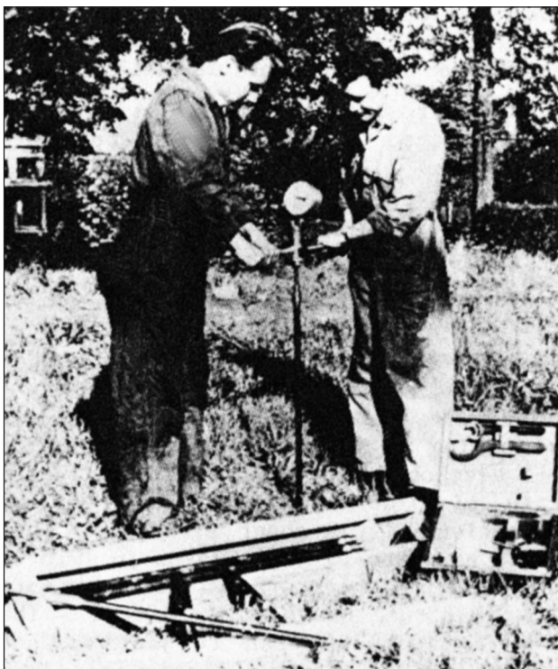
26 pav. Kūginis penetrometras, sukurtas P. Barentseno 1936 m. (pagal Broms ir Flodin, 1988)
