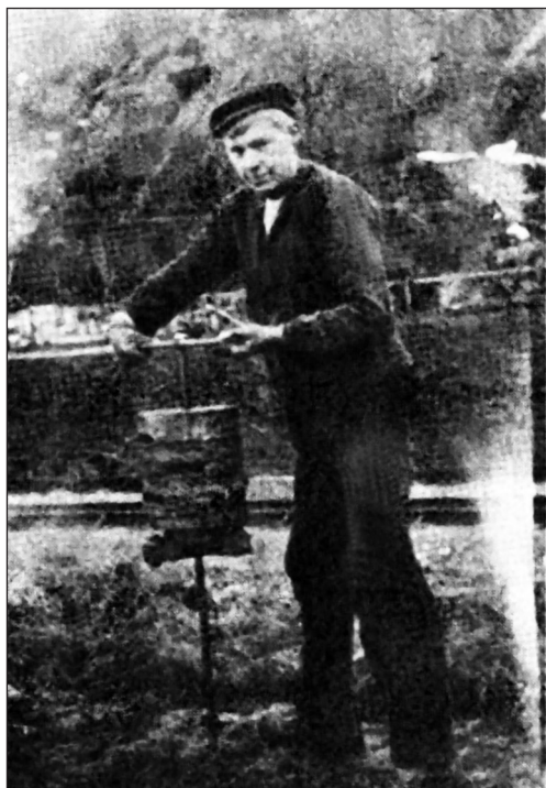
18 pav. Svorinio zondavimo prietaisas, 1917 (pagal Broms ir Flodin, 1988)
