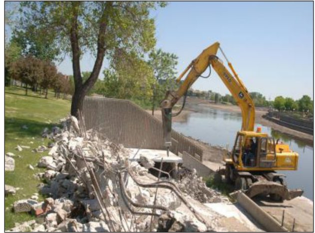
3 pav. Québece nuimamas betonas, 2006 m. Šaltinis: Québeco miesto archyvas
